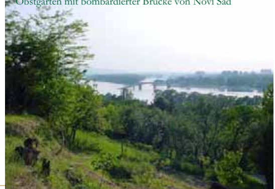
Obstgärten mit bombardierter Brücke von Novi Sad
