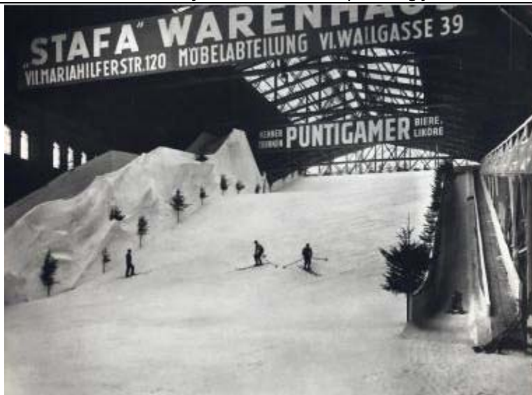
Abbildung: Die Halle im Nordwestbahnhof während der Adaptierung für den Skilauf
