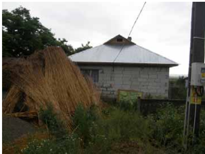
Abbildung 6: Haus im Biosphärenpark vor der Dachdeckung mit Schilf; Quelle: eigene Aufnahme
