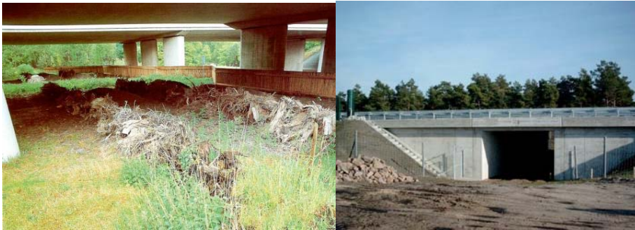
Abb. 14 und 15 Beispiele: Wildtierspezifischen Querungsbauwerk und Wildtierdurchlass
